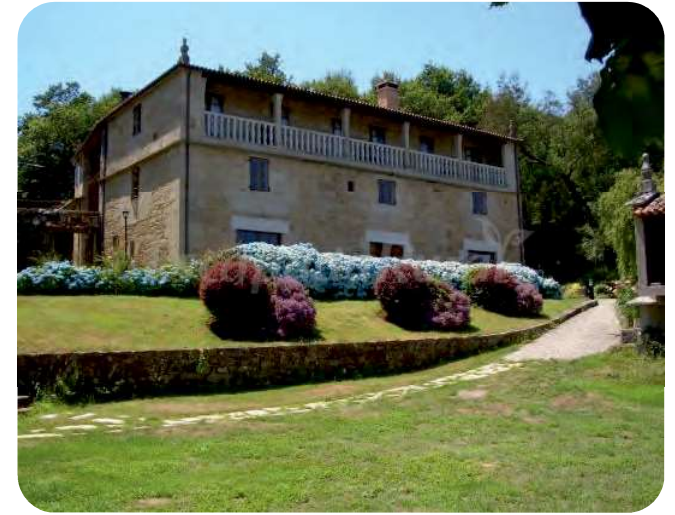
Casa Grande de Fuentemayor - Silleda
